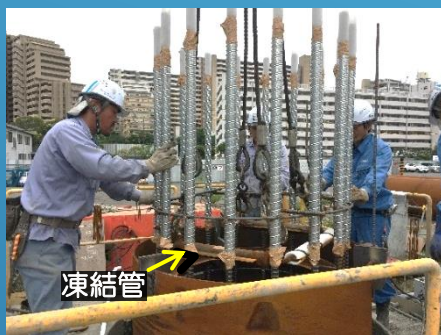
②凍結管取り付け状況
