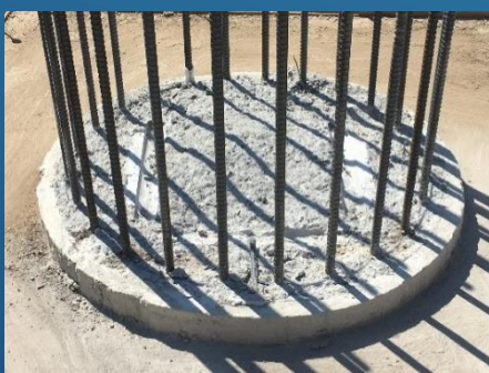
⑧余盛りコンクリート撤去完了 (破碎面)
