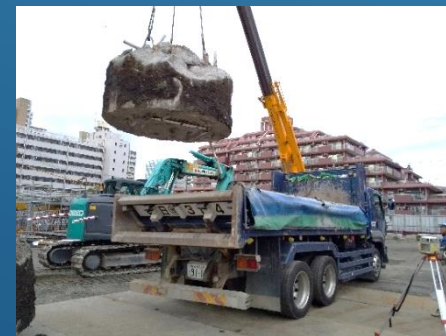
⑨余盛りコンクリート搬出
