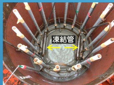
③鉄筋かご建込み状況
