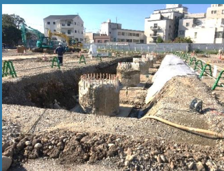
⑤根切り工事完了
